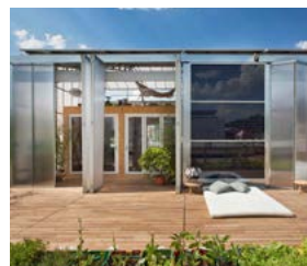
Habitatge solar LOW3 al campus de l'ETSAV, UPC Barcelona (ES)
